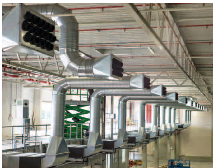
Anschluss von textilen Warmluftkanälen
