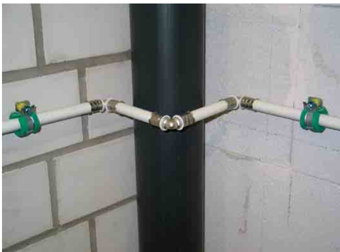
Beispiel Leitungsführung: Eine Richtungsänderung kann mit Formstücken...
