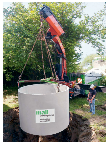
Kein Material ist so gut für den Tief- und Erdbau geeignet wie Beton. Regenspeicher aus Beton sind robust, statisch belastbar, widerstandsfähig gegen Frost und für eine Nutzungsdauer von mindestens 50 Jahren ausgelegt.
