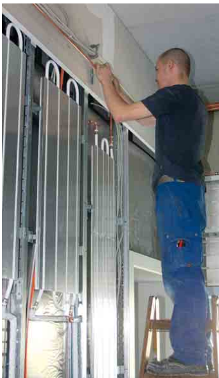
Installation der Anschlussleitung
