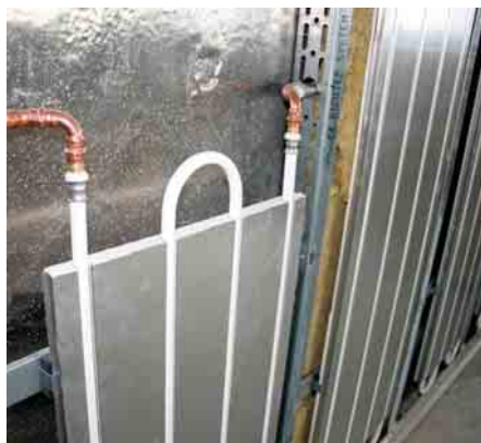
Montiertes cupronova-Element (Ständerwand-Konstruktion); rechts im Bild: mit Dämmung
