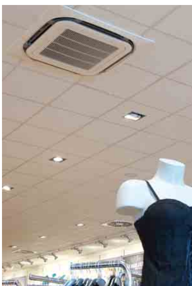
Mit der Roundflow Kassette von DAIKIN wird je nach Bedarf warme oder kühle Luft mit angenehmer 360°-Verteilung in die Verkaufsräume gebracht.
