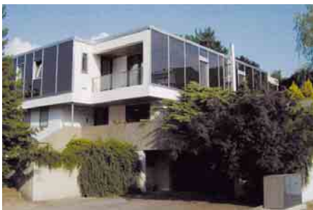
Fassadenkollektoren an einem Flachdach-Bungalow
