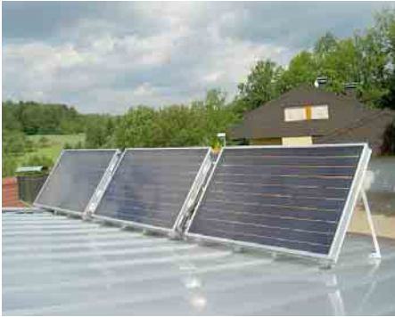
Aufständerung von Flachkollektoren auf einem Blechdach
