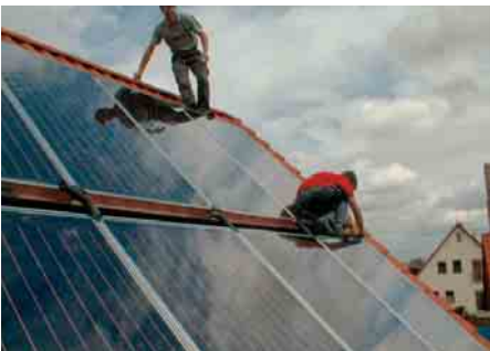
Montage eines Flachkollektorfelds
