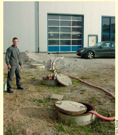
Regenwasserzisterne, Filter- und Pumpenschacht, im Betriebshof eingebaut
