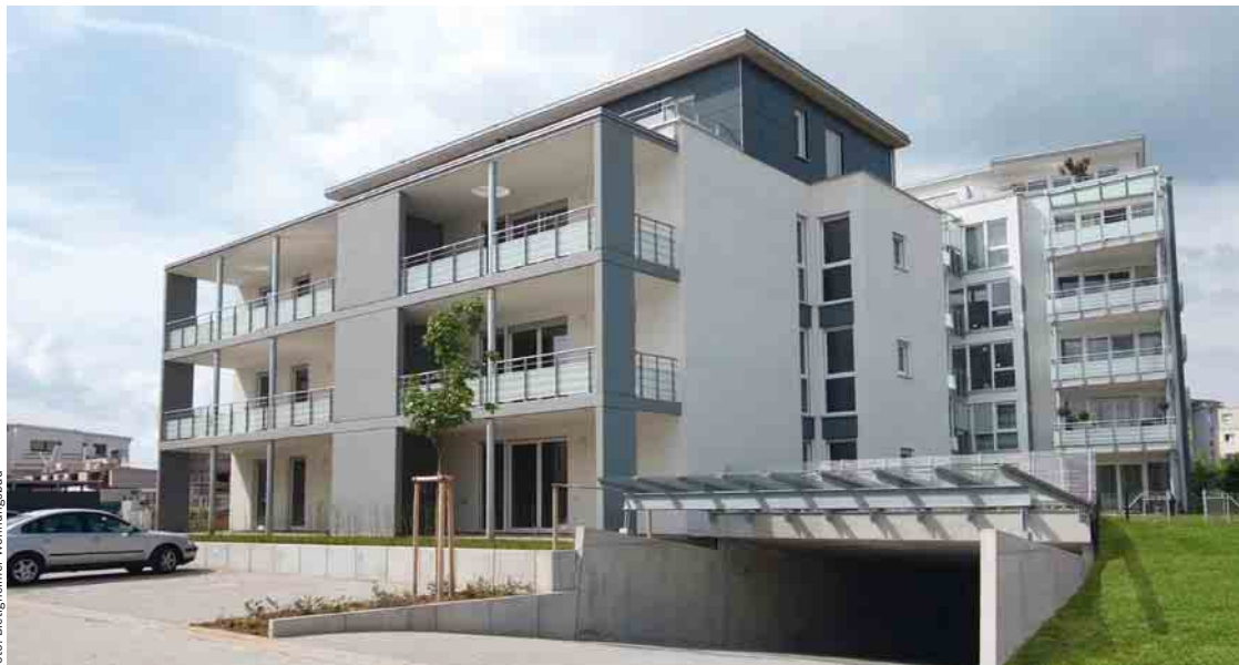
Bietigheim-Bissingen, Max-Born-Straße 22: Hier hat die Energietechnik von morgen bereits Einzug gehalten.
