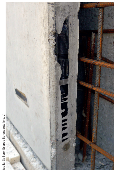
Klima-Wandelement vor dem Betonieren. Das Detail, dem höchste Aufmerksamkeit gilt: der freiliegende Anschluss der Rohrschlangen
