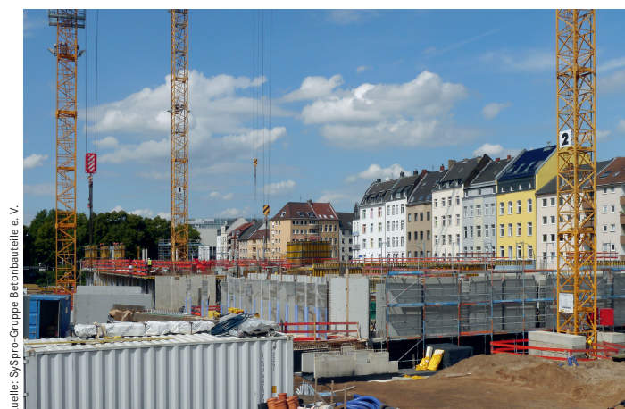
Bauzustand August 2017: EG im Bau; rechts die Randbebauung Eifelwall
