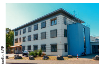
Das Strahlentherapiezentrum wird über eine Wärmepumpenanlage mit Geothermie beheizt und gekühlt.
