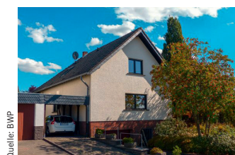
Das Einfamilienhaus in Kehrigh setzt auf eine Wärmepumpe und Radiatoren.
