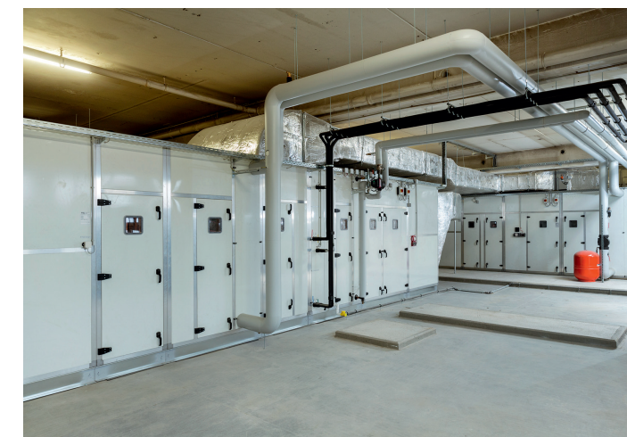
Das Register für den Direktverdampferbetrieb wird direkt in das Zentrallüftungsgerät eingebunden.
