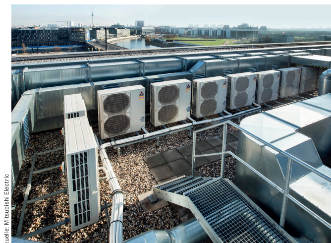
Durch eine Kaskadierung von bis zu sechs Außeneinheiten (Mr. Slim-Serie) lassen sich Leistungsbereiche von bis zu 132 kW Kälte- bzw. 162 kW Heizleistung abbilden.
