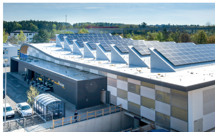
Die nach Süden ausgerichteten Sheddächer tragen die Photovoltaik-Anlage, deren Strom direkt zum Betrieb der Kühltheken genutzt wird.
