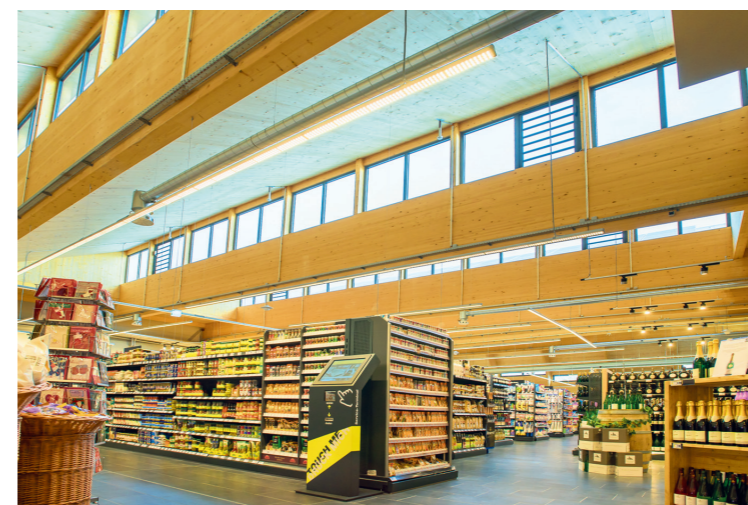
Der Supermarkt besticht durch sein Tageslicht-Beleuchtungskonzept und durch die hybride Konstruktion aus Holz und Stahlbeton.
