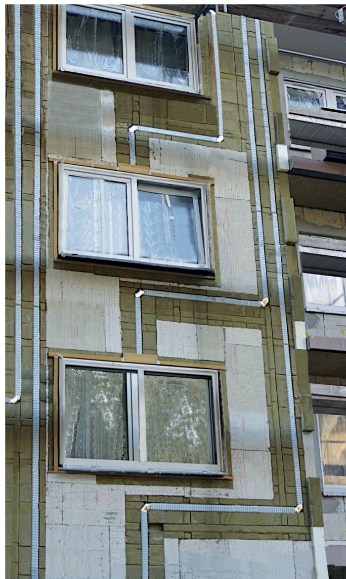
Europäisches Forschungsprojekt „RetroKit“: Sanierung der Fassade mit Integration der Zu- und Abluftleitungen in die Außendämmung
