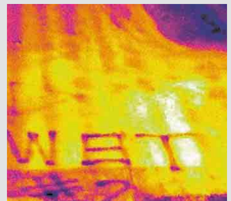
Durchfeuchtetes Flachdach
