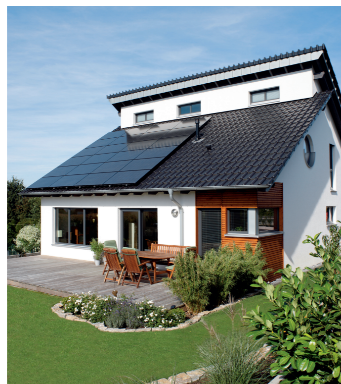
Smart Grid – Eigenstrom aus PV-Anlage für die Wärmepumpe
