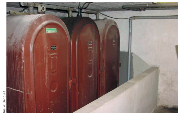
Stahlbatterietanks werden seit Anfang der 1970er Jahre nicht mehr hergestellt, die untere Umlaufleitung ist ein Gefahrenpotenzial.
