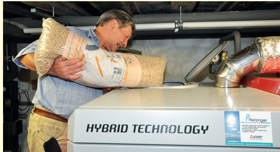
Bei dem so genannten Scheitholzvergaser-Pellet-Kombikessel (SP-Kombis) handelt es sich um einen Hybridkessel, der wechselweise die beiden Brennstoffe Scheitholz und Holzpellets verbrennen kann.
