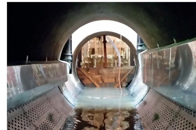
Die 86 m lange Wärmeübertragerstrecke im Mischwasserkanal mit 1,5 m Durchmesser liefert die Wärme für den 1. Bauabschnitt des neuen Wohnquartiers Alter Stadthafen.
