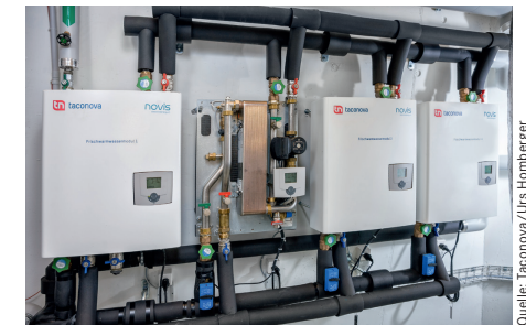
Quelle: Taconova/Urs Homberger Vier TacoTherm Fresh Peta X-Stationen wurden als 4er-Kaskade miteinander gekoppelt, um auch in Spitzenzeiten immer ausreichend Frischwarmwasser zur Verfügung zu stellen.
