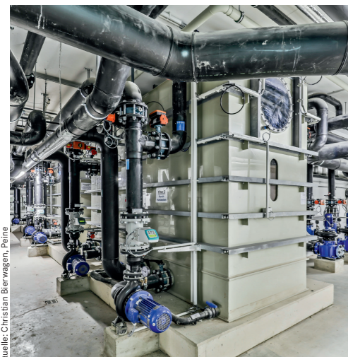
Schallwasserbehälter mit Mannloch
