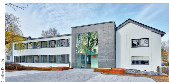
Der Altbau wurde komplett saniert und ebenfalls mit der VRV-Technologie ausgestattet.
