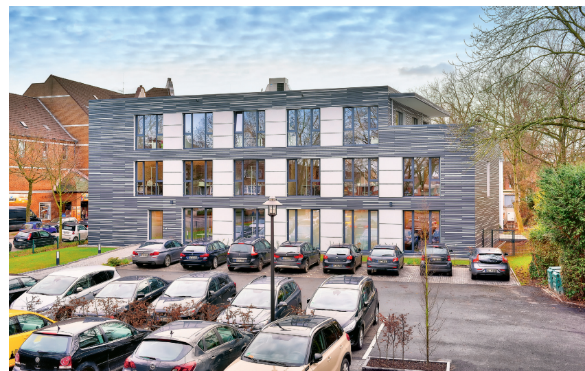
Im dreistöckigen Neubau der Hamborner REIT AG in Duisburg werden alle Büro- und Besprechungsräume mit der VRV-Technologie klimatisiert.
