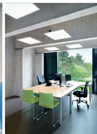
Büroraum an der Gebäudenordseite mit opaker hochdämmender Vakuum-Isolierverglasung in den Öffnungselementen
