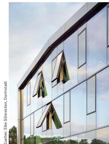
Nordfassade in Structural- Glazing-Optik
