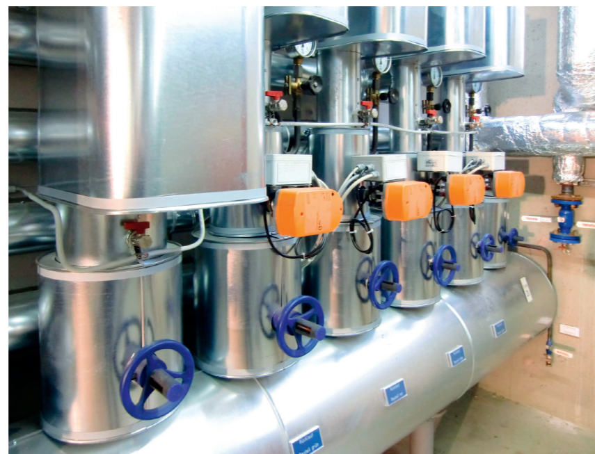
In großen Heizungsanlagen oder Kühlwassersystemen führen Kalk und Schmutz im Wärmeträgermedium Wasser zur Verminderung der Energieeffizienz und zu Schäden an Pumpen und Armaturen.
