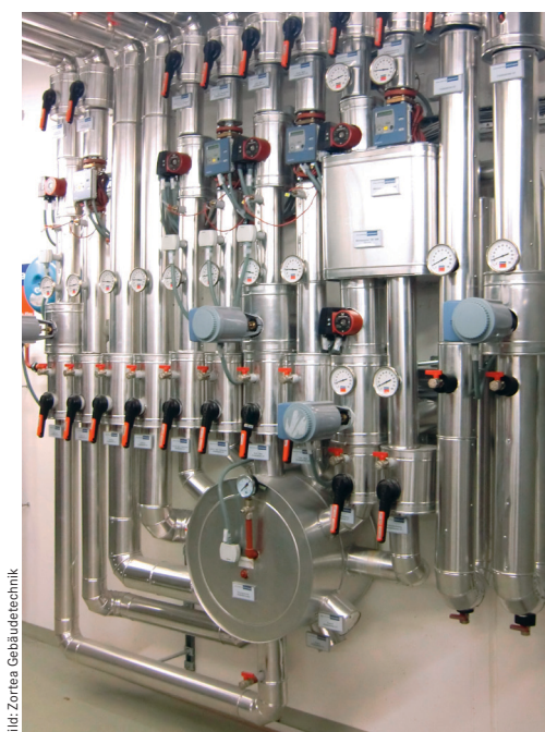
Die Zortea-Technologie führt die Heizwasserströme von Wärmeerzeugern und Abnehmerkreisen auf einen hydraulischen Nullpunkt zusammen.
