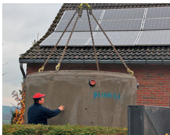
Nachrüstung der Regenwasserzisterne durch Bauunternehmer Lemmens, Gemmenich
