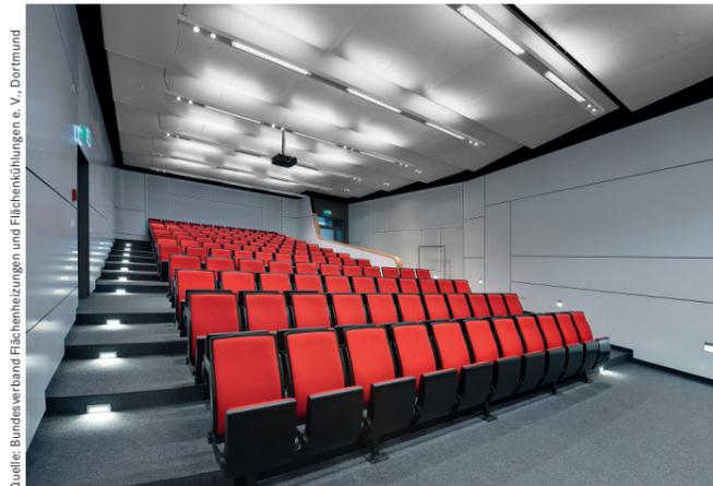
Eine Flächenkühlung in Form von Trockenausbauplatten unter der Decke lässt viele Gestaltungsmöglichkeiten zu.
