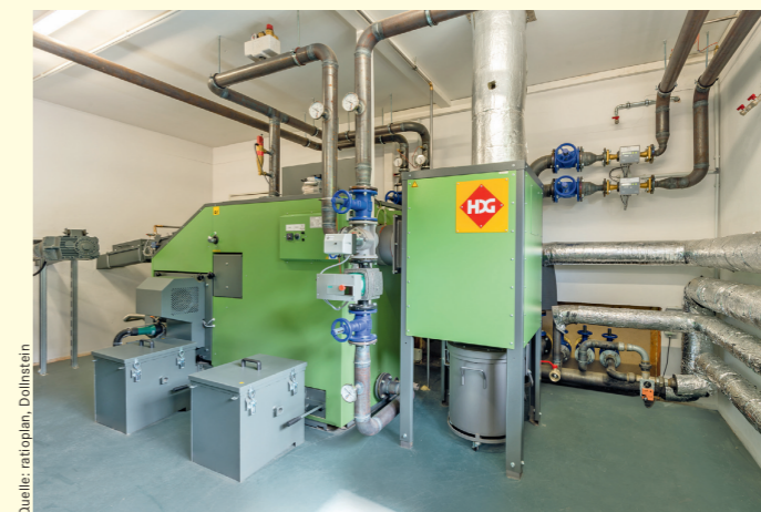
Ein zentrales Element eines kalten Nahwärmenetzes ist die so genannte Heizzentrale. Im Falle der Gemeinde Bodenmais sorgt eine 2 x 200 kW Hackgut-Anlage für die primäre Energiegewinnung.
