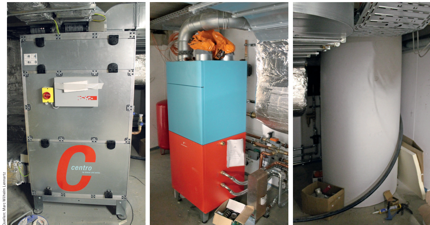
Zum Versorgungsmosaik des Smart Home gehören die kontrollierte Lüftungsanlage mit Wärmerückgewinnung (links), eine Wärmepumpe (Mitte) und der Pufferspeicher für den Betrieb der Flächenheizung (rechts).
