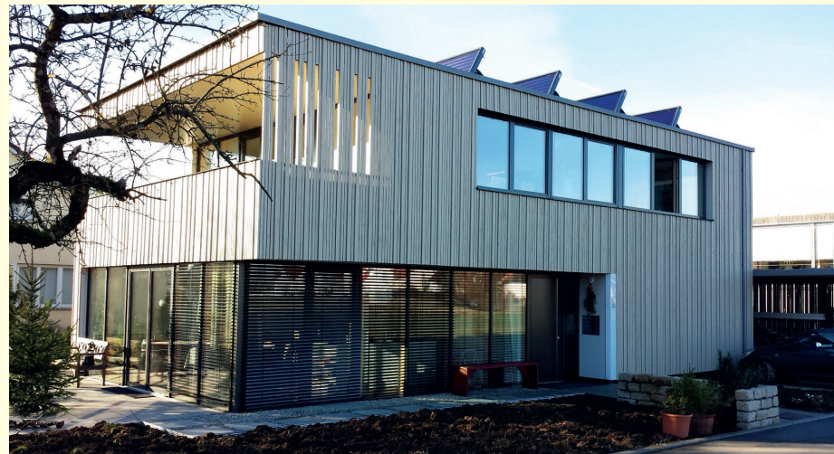
Bei diesem Sonnenhaus in Baden-Württemberg decken 24 m² Solarkollektoren auf dem Flachdach ca. 65 % des Wärmebedarfs.
