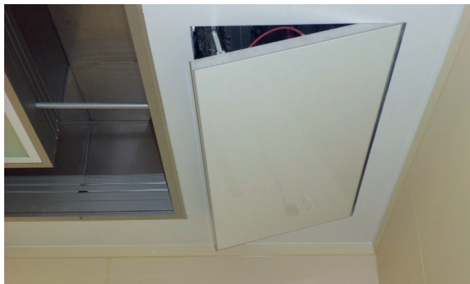
2 ASKLEPIOS Krankenhaus Seligenstadt, Operationssaal der Raumklasse Ia mit Medienversorgungsbrücke, Infrarot-Deckenheizplatten ausgeführt als Revisionsöffnungen. 2011
