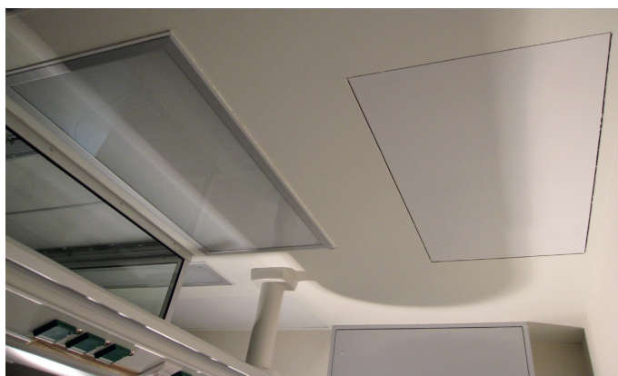
3 Orthoparc Köln, Operationssaal der Raumklasse Ia mit Medienversorgungsbrücken, Infrarot-Deckenheizplatten ausgeführt als Revisionsöffnungen. 2011
