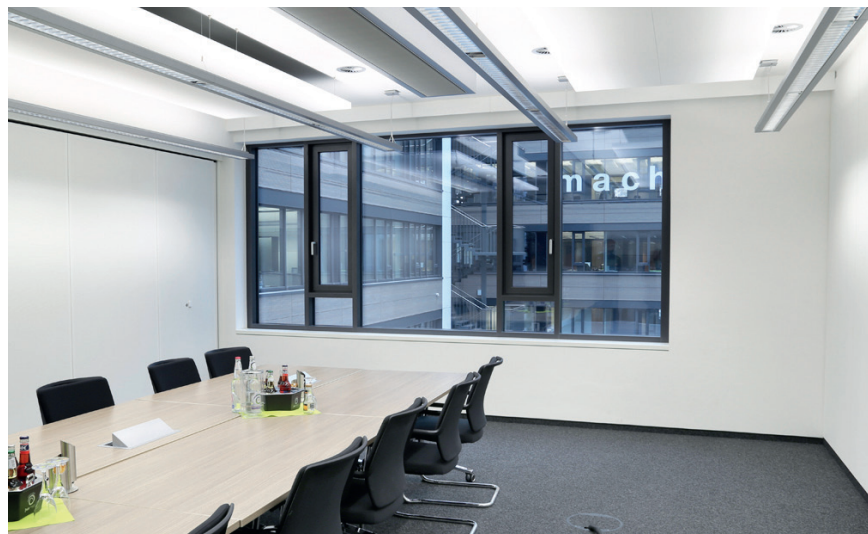
In den Besprechungsräumen wird die Luft aus dem Concretcool-System in zusätzlich installierte, schnell reagierende Hochleistungs-Kühlpaneele Inducool Compact geleitet, mit einer wasserseitigen Leistung von 300 W/lfm zur zusätzlichen Raumkonditionierung.
