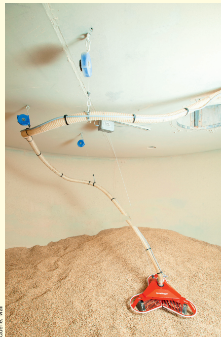
Das Entnahmesystem Maulwurf im Pelletspeicher wird zum Befüllen des Speichers hochgezogen.
