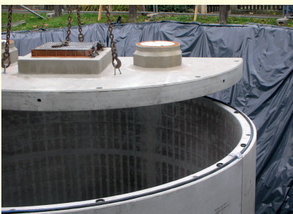
Pelletspeicher in den Außenanlagen unterirdisch eingebaut, Montage der verschraubten Betonfertigteile
