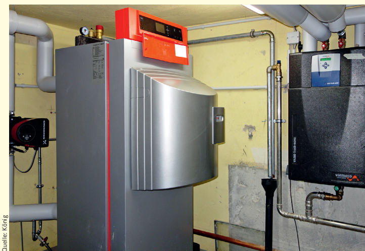
Spitzenlastkessel mit Gas-Brennwerttechnik 130 kW (links), Trinkwasserstation (rechts)
