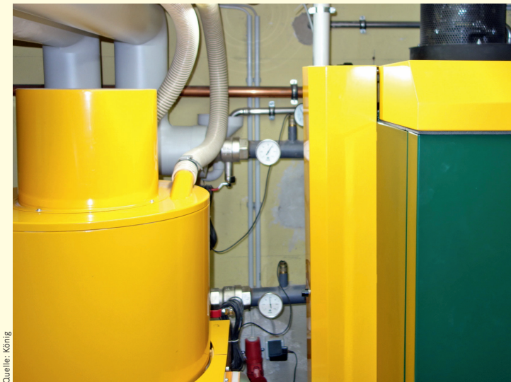
Grundlast-Pelletkessel 80 kW (rechts), Saugturbine (links) mit flexiblen Leitungen nach oben zur Außenwanddurchführung in Richtung Pelletspeicher
