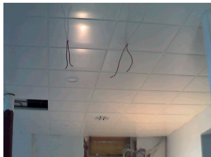
Um die besonderen hygienischen Anforderungen im Klinikum zu erfüllen, kamen ausschließlich glatte Elemente ohne Mikroperforierung zum Einsatz.
