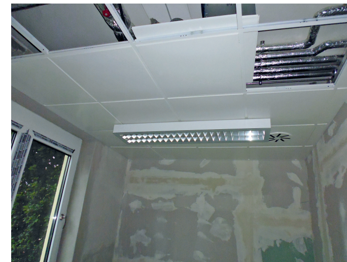
Die Konstruktion lässt sich schnell und ohne Federn oder Bolzen einspannen, die Aufhängung an der Decke erfolgt über Aufhänger und Federn.
