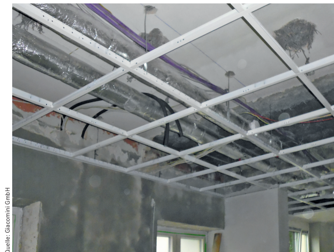
Die Platten wurden auf einer sichtbaren Leichtmetall-Konstruktion mit T-förmigen Trägerprofilen mit 24 mm-Basis montiert. Dieser Aufbau entspricht einem kommerziellen Standard.
