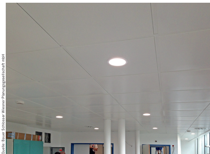
Im Rahmen der Baumaßnahmen an der Salzachklinik Fridolfing wurde in Aufwachraum und Sterilbereich eine Klimadecke angebracht.
