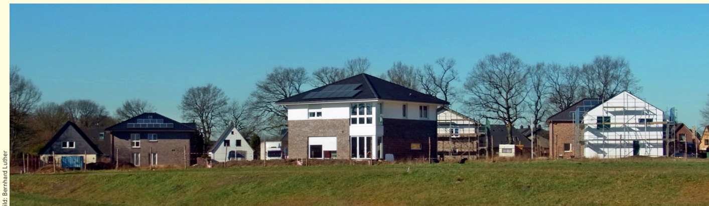
Die im Bau befindliche Solarsiedlung in Norderstedt gilt als Pilotprojekt der beteiligten Partner.
