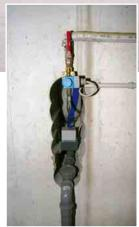
Rückansicht: Bei den "Centaurus"-Hybrid-Urinalen wird die Spülung über Magnetventile ausgelöst, die mittels Zeitschaltuhr gesteuert werden. Da die Urinale auch für wasserlosen Betrieb geeignet sind, erfolgen die Spülungen nicht nach jeder Nutzung, sondern in großen zeitlichen Intervallen.
