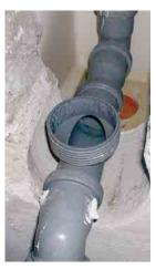
Um jederzeit die Abwasserrohre auf Inkrustationen überprüfen zu können, wurde am Abgang der Urinale ein abschraubbarer Revisionsdeckel vorgesehen. Der Blick in die Rohre zeigt, dass sich auch nach monatelangem Betrieb keine Ablagerungen gebildet haben.
