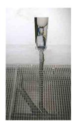
Hinter den Urinalen befindet sich ein großzügiger Revisionsgang, durch den die Abwasserleitungen verlaufen. Im Wanddurchbruch wurde ein Mess-Sensor nebst Zähleinheit untergebracht, um jede Nutzung des Urinals zu erfassen.
