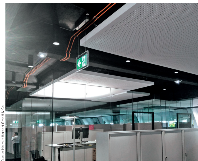
Die freihängenden Deckensegel sorgen für ein behagliches Büro-klima.
