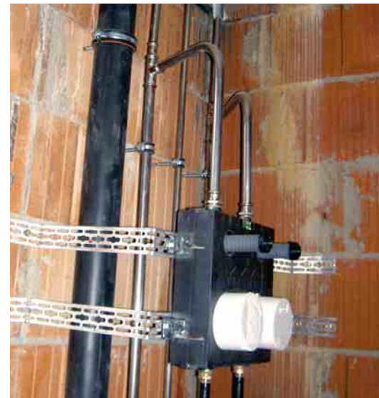
Massivschächte F90: Installationsschächte mit WERIT IBS 90, die mit klassifizierten Schachtwänden erstellt werden, benötigen für die Schachtdurchdringungen von Rohrleitungen, Armaturen oder Sanitärelementen keine kostenintensiven und feuerwiderstandsfähigen Durchführungen. Das Bild zeigt einen Schachtaufbau mit WERIT IBS 90 Deckenplatte, noch nicht gedämmten Ver- und Entsorgungsleitungen und einer Mess- und Absperrstation ohne Feuerwiderstandsdauer.
