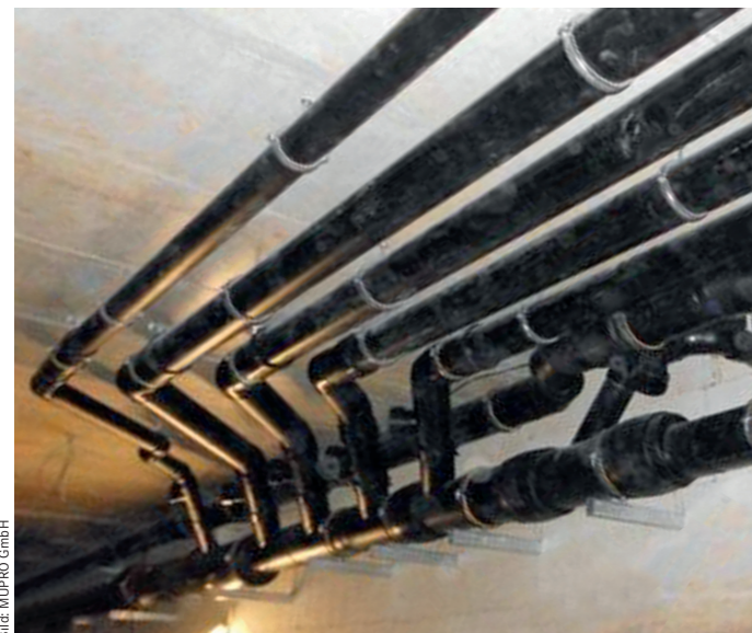
Beispiel für fachgerecht installiertes Entwässerungssystem – PE-Rohr und Langmuffen, fixiert mit Festpunkten
