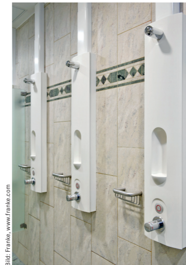
Eine Alternative zu den Duschpaneelen mit Glasfront stellen die MIRANIT-S Gehäuse aus stabilem Mineralgussmaterial dar (Saarow Therme, Bad Saarow).
