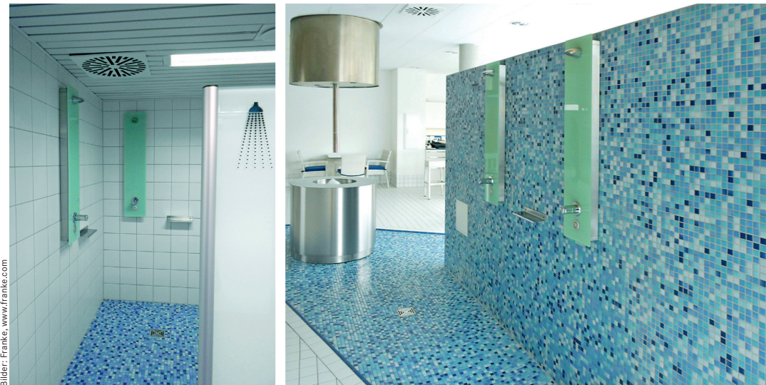
Optisch ansprechend und funktional: Die Front der Duschpaneelle besteht aus Sicherheitsglas.
