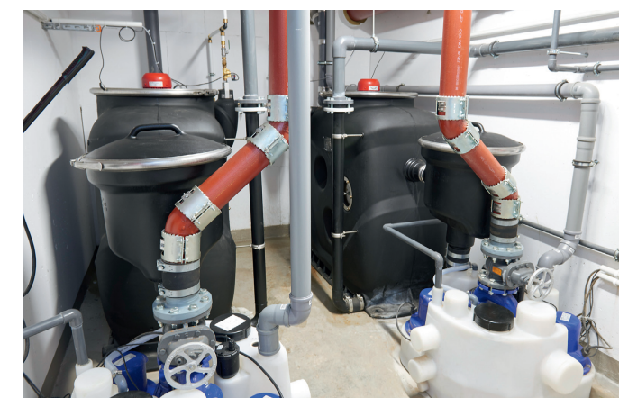
Für die Reinigung des in den Gastronomiebereichen anfallenden Abwassers sind die beiden TECESepa S Fettabscheider zuständig.
