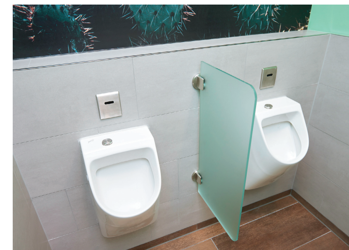
Der Infrarotsensor ermöglicht eine berührungslose Spülauslösung und sorgt so für mehr Hygiene auf der Herrentoilette.
