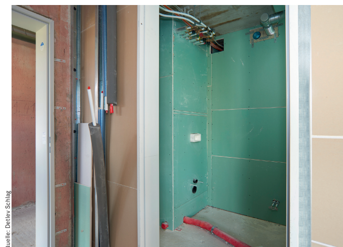
Eine Trockenbauwand trennt die beiden Bäder voneinander. Der Gast merkt hiervon nichts.
