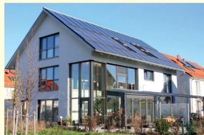
Mit 45 m<sup>2</sup> Solarkollektoren können rund 60 % des Heizenergiebedarfs für die Raumheizung und das warme Wasser solar gedeckt werden. Die PV-Anlage erzeugt Strom für den Haushalt, die Haustechnik und Elektrofahrzeuge.
