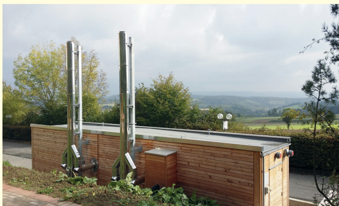
Nach der Aufstellung wurden das Nahwärmenetz und die Elektroversorgung sowie der Edelstahl-Schornstein parallel zum Gebäude installiert.
