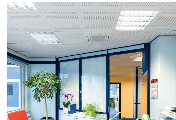
Bei dem patentierten R22 Replace Verfahren brauchen nur die Altgeräte ausgewechselt werden und das alte Rohrsystem kann im Gebäude verbleiben.
