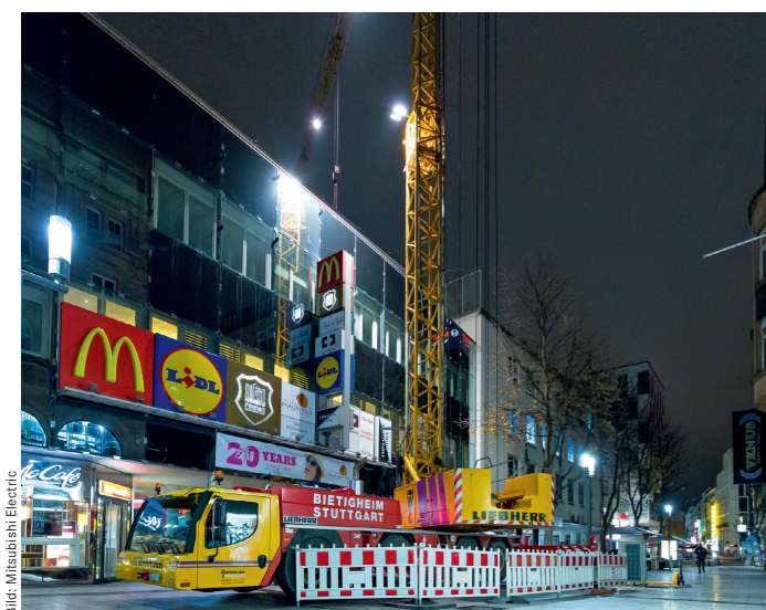
Mit einem mobilen Auslegerkran werden die Außengeräte in der Stuttgarter Innenstadt in kurzer Zeit ausgetauscht.
