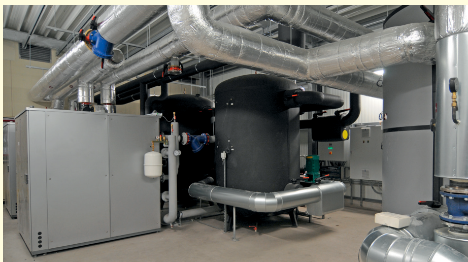
Die Absorptionskältesysteme am VELUX Produktionsstandort Sonneborn
