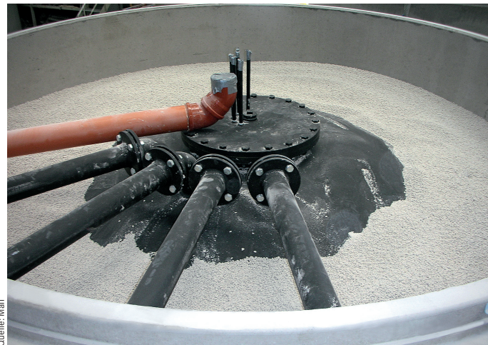
Fernwärmenetz Murg-Niederhof. Unterirdischer Pufferspeicher, Anschlussleitungen
