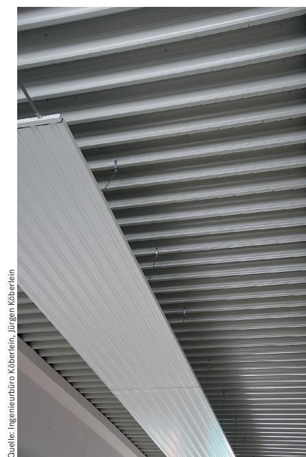
Vereinfachte Montage der Technik durch die richtige Wahl der Dacheindeckung
