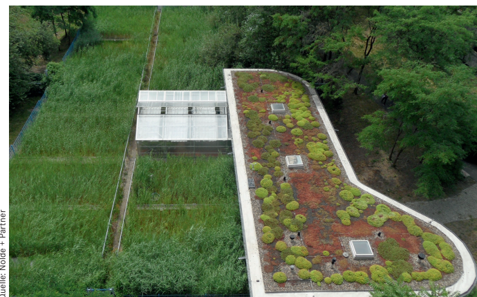
Betriebsgebäude aus dem Jahr 2007 für Grauwasser- und Schwarzwasser-Recycling im Innenhof des Blocks 6, Berlin-Kreuzberg. Quer angesetzt wurde 2014 das Gewächshaus der Roof Water-Farm.
