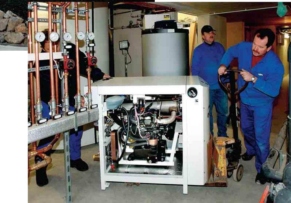
**Installation und Inbetriebnahme des ecopower Mini-BHKWs konnten durch anschlussfertige Lieferung innerhalb kürzester Zeit von der Firma Schuricht und Kurth GmbH abgeschlossen werden.**
