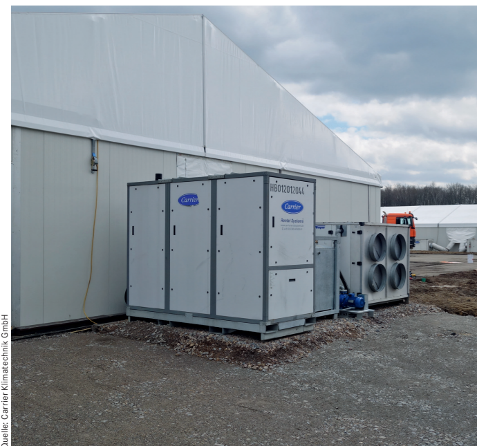
Für den Betrieb von Zelten, in denen sich viele Menschen aufhalten, ist eine effektive Frischluft- und Wärmeversorgung von zentraler Bedeutung. Ein kombiniertes Wärmeerzeugungs- und Belüftungssystem ist im Bedarfsfall auch sehr kurzfristig installierbar.
