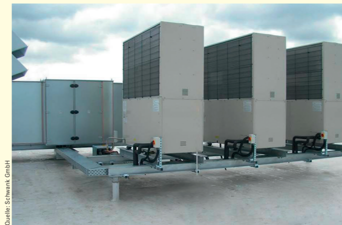
3 – Dachmontage von drei Gasmotorwärmepumpen
